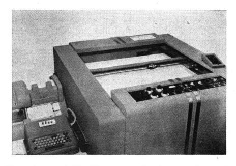
Abb. 9. «Automatic Line Plotter» zum Kartieren von Querprofilen aus Lochkarten- oder Lochstreifenangaben
