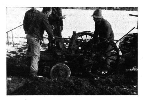
Abb. 3. Der Maulwurfspflug steht rittlings über der Kupplungsgrube
