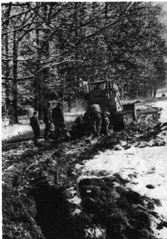
Abb. 5. Trax und Maulwurfspflug kurz nach einer Kupplungsgrube mit leichter Richtungsänderung
