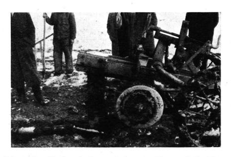
Abb. 4. Der Maulwurfspflug nach dem Ausfahren mit Vorkörper, Maulwurfskörper und Spezialkupplung
