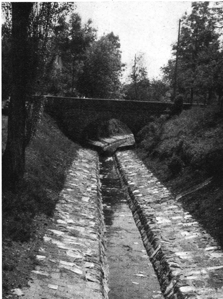
Korrektur des Altstätter Stadtbaches im unteren Teil unter Schonung der bestehenden Baumpflanzungen und der alten steinernen Straßenbrücke der Montlingerstraße.
