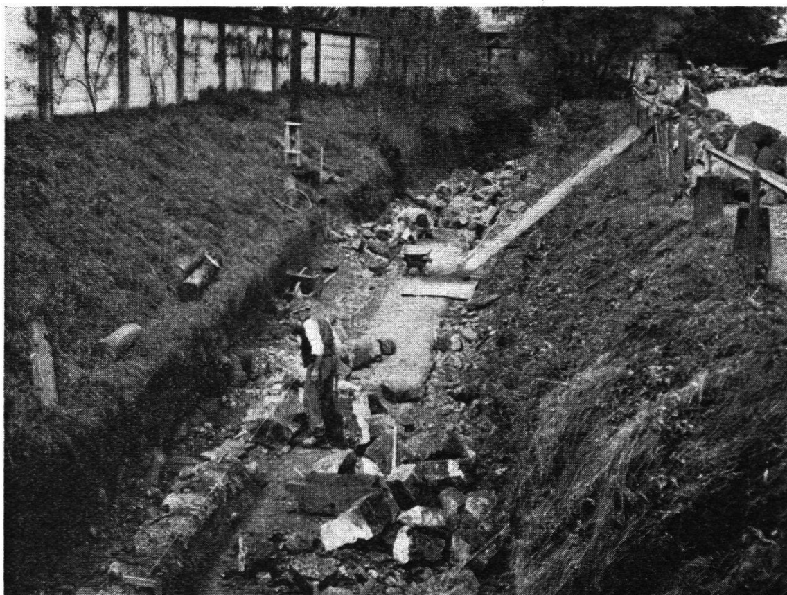
Beginn der Bauarbeiten im Oberlauf. Die Niederwasserrinne zeichnet sich bereits ab, während die ursprüngliche Struktur des Uferschutzes noch deutlich erkennbar ist. Jeder Anstößer hat denselben nach seinem Gutdünken erstellt.
