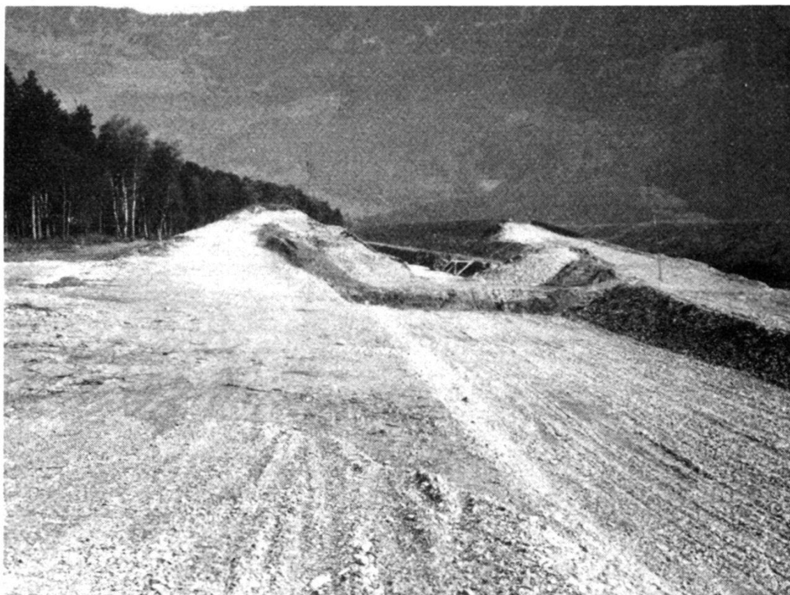
Übergang des fertigen Kanalstücks zur Baustelle. Man erkennt das gepflästerte Doppelprofil mit Rasenböschung. Die Kanalsole liegt höher als der Talboden.
