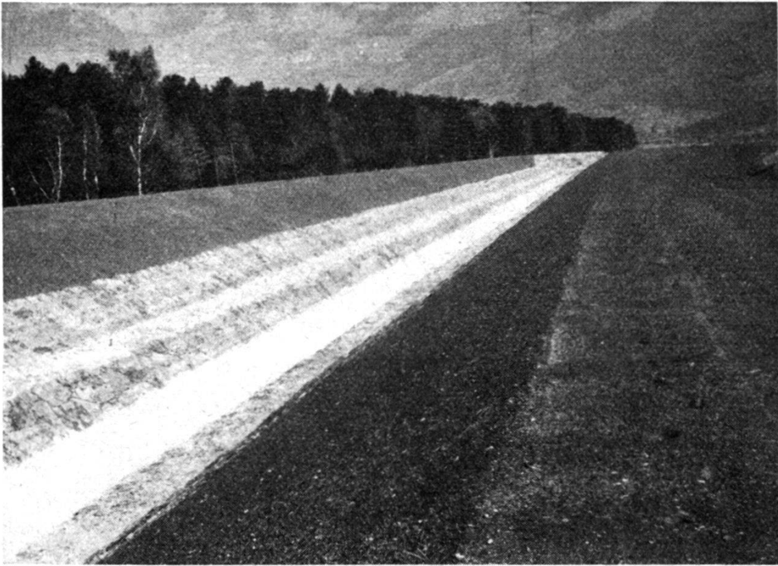
Das fertige untere Kanalstück, talabwärts gesehen, mit Betonsohle, gepflastertem Doppelprofil und Rasenböschung. Die Dammkronen des neuen Kanals sind gleich hoch wie der Rheindamm.
