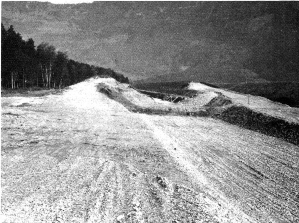
Übergang des fertigen Kanalstücks zur Baustelle. Man erkennt das gepflästerte Doppelprofil mit Rasenböschung. Die Kanalsohle liegt höher als der Talboden.
