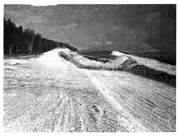
Übergang des fertigen Kanalstücks zur Baustelle. Man erkennt das gepflästerte Doppelprofil mit Rasenböschung. Die Kanalsohle liegt höher als der Talboden.
