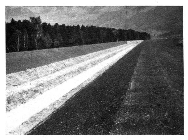
Das fertige untere Kanalstück, talabwärts gesehen, mit Betonsohle, gepflästertem Doppelprofil und Rasenböschung. Die Dammkronen des neuen Kanals sind gleich hoch wie der Rheindamm.
