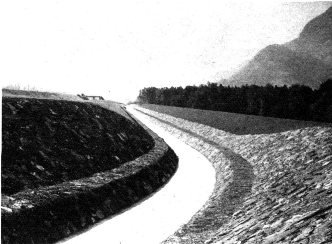
Die Kurve vor dem Rheindamm, wo später durch eine Bresche in denselben sich die Wasser der Saar in den Rhein ergießen. Die Böschungen der Kurve sind bis an die Dammkrone gepflästert. Blick talaufwärts des fertigen Kanalstückes.
