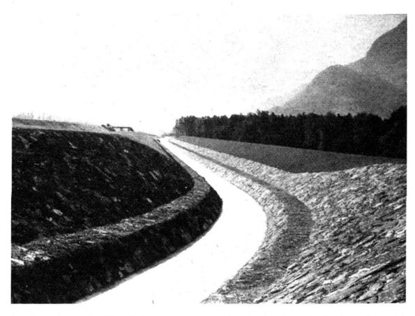
Die Kurve vor dem Rheindamm, wo später durch eine Bresche in denselben sich die Wasser der Saar in den Rhein ergießen. Die Böschungen der Kurve sind bis an die Dammkrone gepflästert. Blick talaufwärts des fertigen Kanalstückes.
