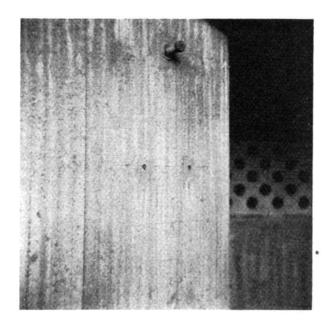
Abb. 2. Spezialmeßbolzen mit Steinschraubenmuttern zur Befestigung der Geräthalterung
