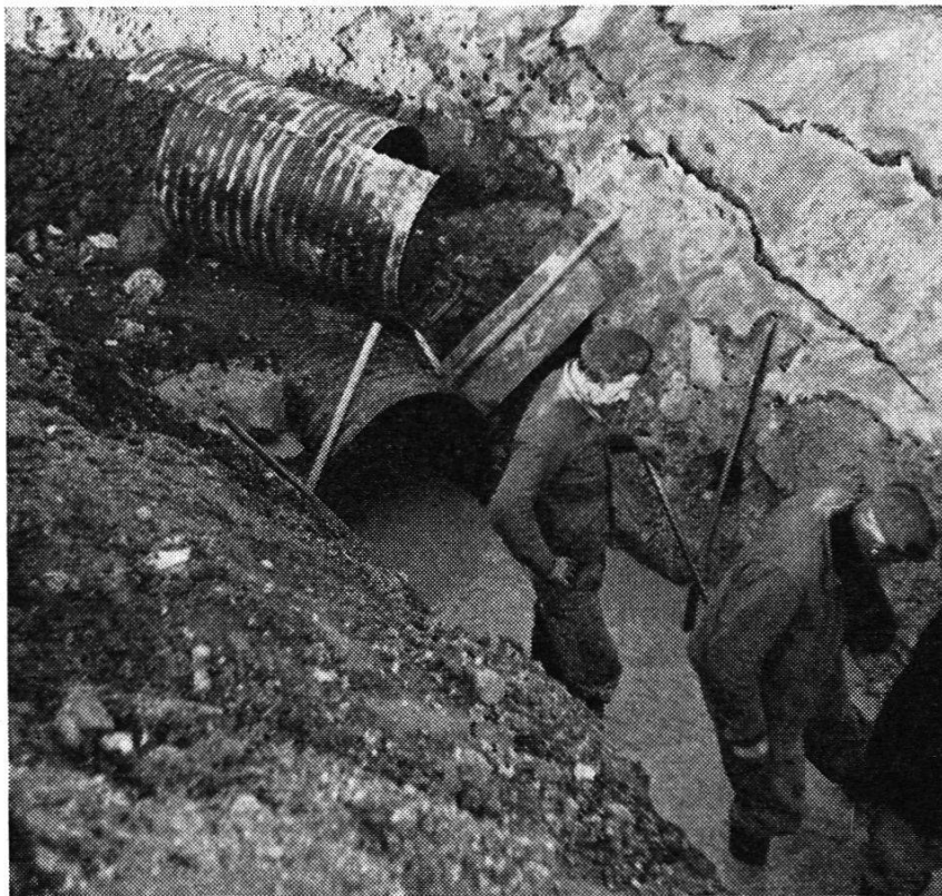
Pose d'une canalisation de 80 cm de diamètre
