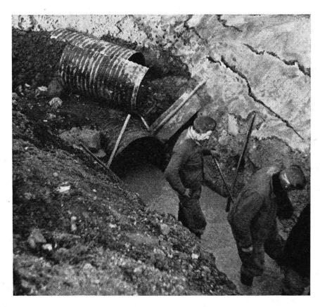
Pose d'une canalisation de 80 cm de diamètre
