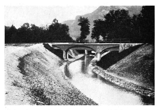
Fig. 5. Acqueducs de la Grande-Eau et du bief industriel de la Monneresse sur le Grand-Canal. Différence d'altitude des plans d'eau: 4.80 m.
