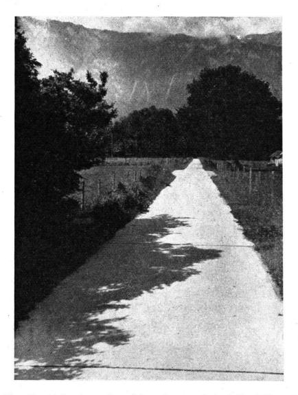
Fig. 10. Aigle, chaussée en béton, largeur de la dalle: 2.80 m.
