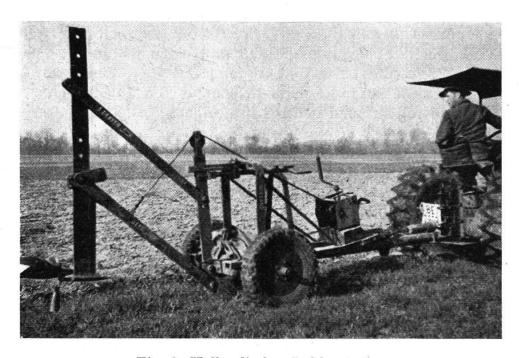
Fig. 2. Holländischer Dekker-Pflug. Schwert mit Maulwurf und Preßkopf am beweglichen Parallelogramm befestigt
