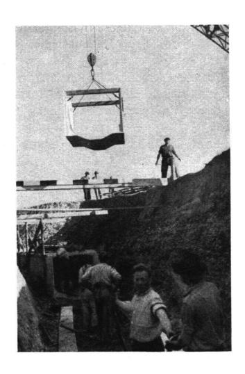
Anschließend erfolgte sodann der Grabenaushub mit Bagger. Dabei konnte erfreulicherweise festgestellt werden, daß die Baugrube vollständig trocken war und daß namentlich das sonst einsturzgefährliche Material festhielt. Eine Sprießung der Wände war nicht mehr notwendig.
