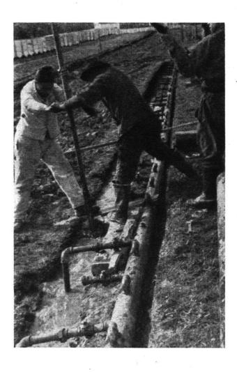
legt Diese Saugrohrleitung ist in Abständen von 1,20 m mit Abzweigungen für den Anschluß der Saugbrunnen versehen.
