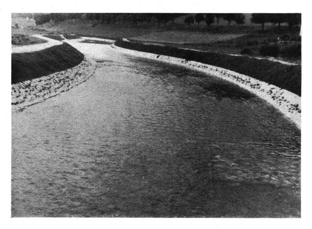
Korrektion der Areuse. Fertig ausgebaute, durch ihre gewundene Linienführung gekennzeichnete Flußstrecke oberhalb La Presta.
