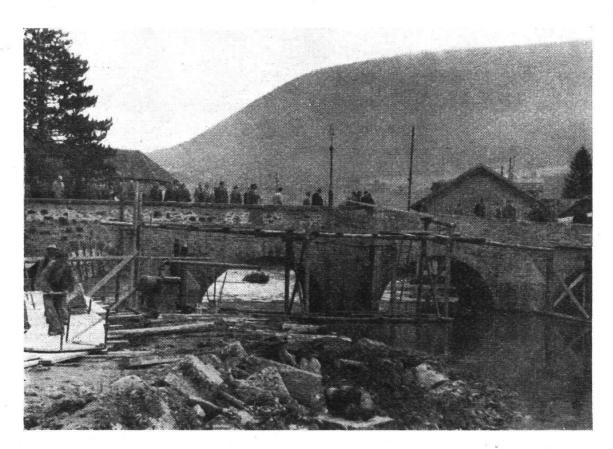
Korrektion der Areuse. Alte, durch Injektionen und Unterfangung zu erhaltende Areuse-Brücke in Travers.
