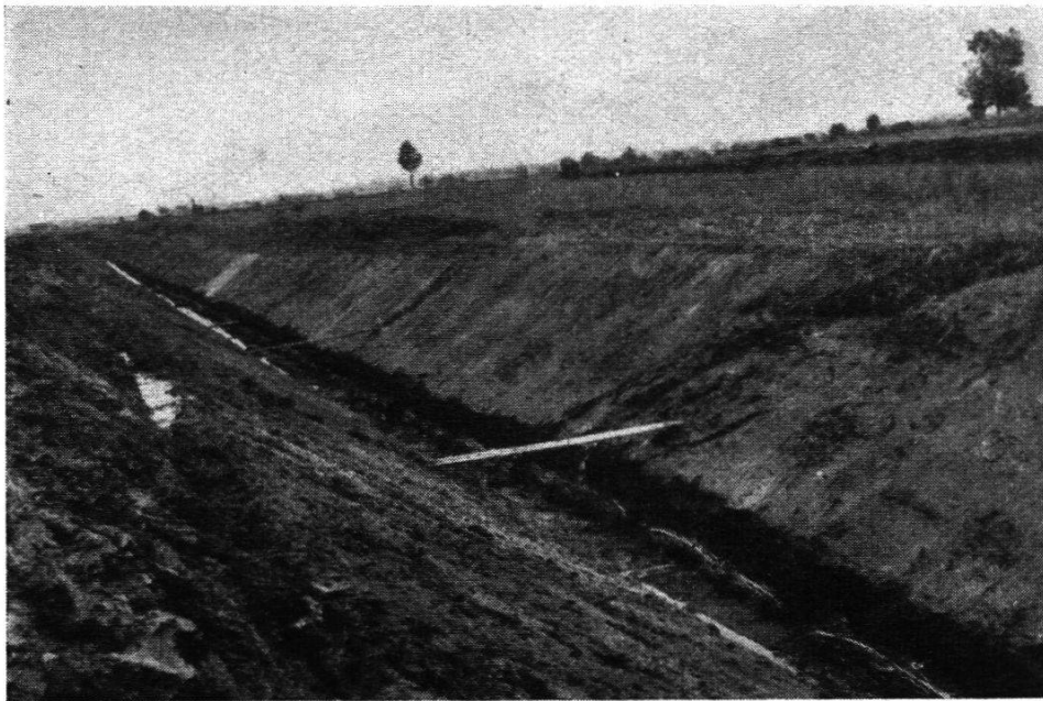
Faschineneinbau zur Sicherung der Böschungsfüße Abbildung 4
