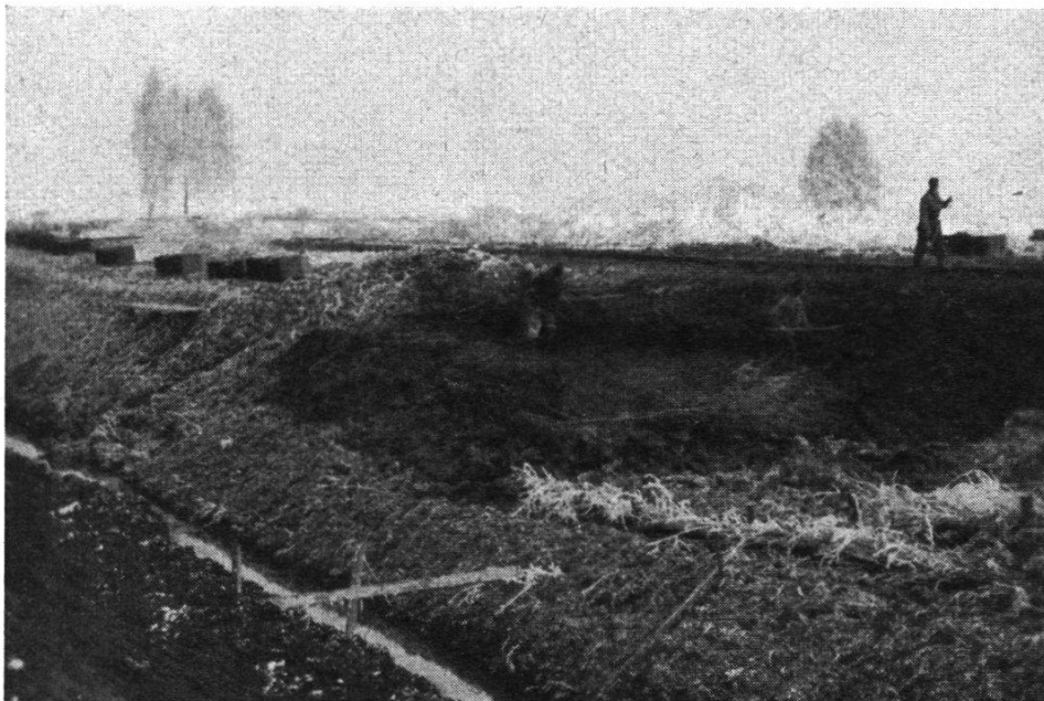
Ausfüllen eingestürzter Böschungen mit Stauden und Torf
