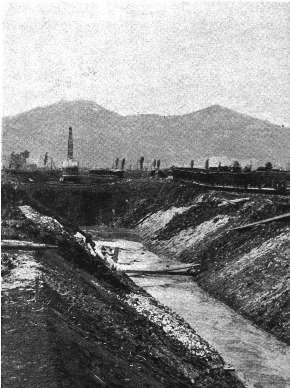
Mittlerer Seegraben, Grundwasser-Aufstoß mit Triebsand Abbildung 3
