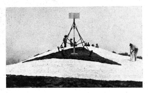
Abbildung 6. Triangulation Trujillo. Punkt II. Ordnung, mit Markierung für Luftaufnahmen
