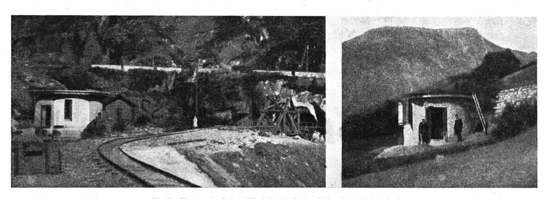
Fig. 23. Observatorien Süd und Nord der Simplontunnel-Absteckung. (Basispunkt:.)
