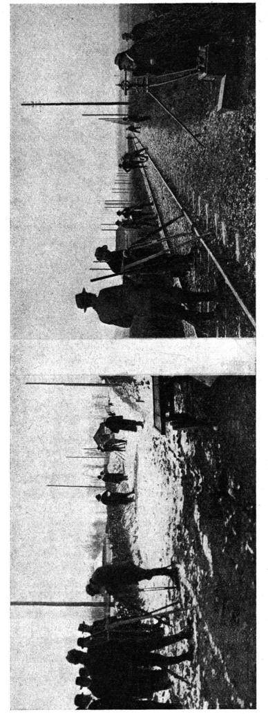
Fig. 28 a. Basis Ostermundigen: Bestimmen der Distanz zwischen den beiden Marken durch gleichzeitiges Ablesen der Maßstäbchen.
