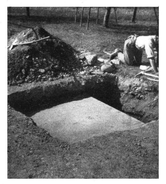
Fig. 16. Basisanfang Aarberg: 1927 bloßgelegte Deckplatte.
