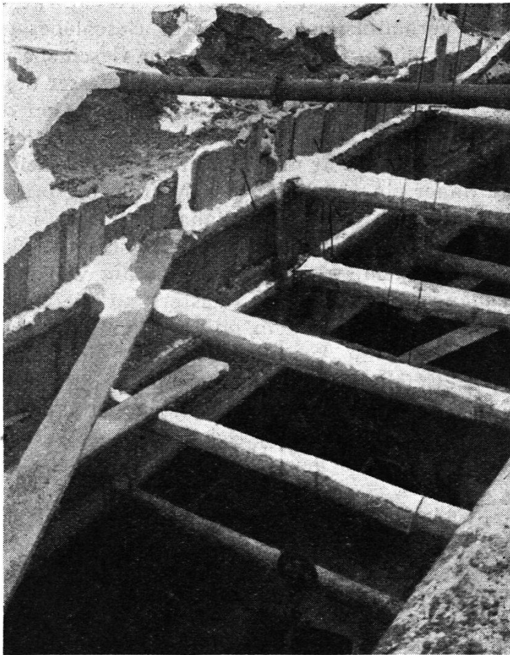
Abb. 4. Aushub der Fundamente.
