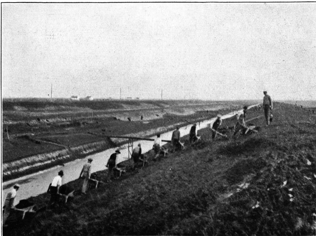
Abb. 4. Bonifica Parmigiana-Moglia. Ausheben eines Kanales im Handbetrieb.
