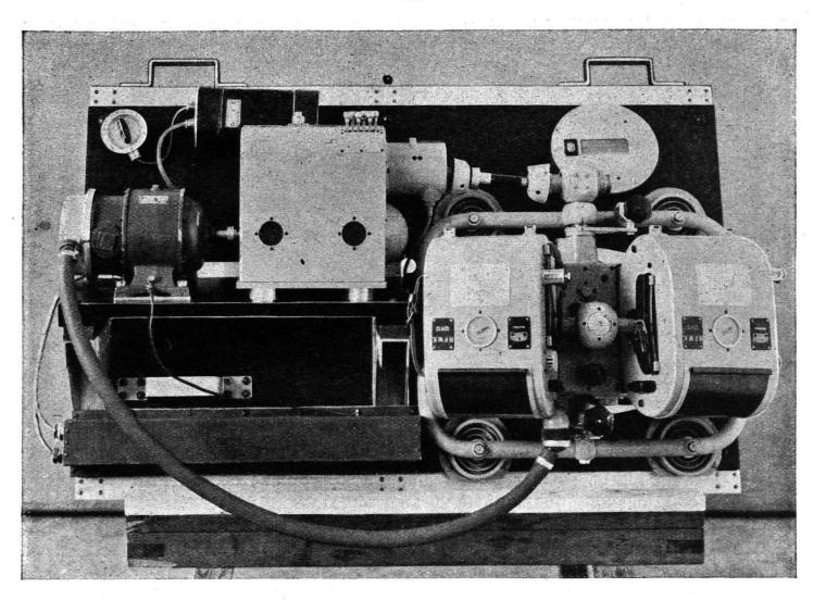
Fig. 2. — La chambre double "Zeiss-Aerotopograph" pour prises de vues en séries, montée pour des levers obliques, avec électro-moteur, régulateur de recouvrement et mécanisme à régime variable.
