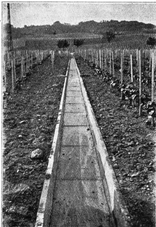
Gargouilles pour évacuation des eaux de surface.
