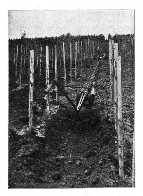
Fig. 5. Charrue double viticole à avant-train, tirée par le Cabestan-Lederrey.
