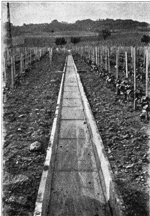
Gargouilles pour évacuation des eaux de surface.
