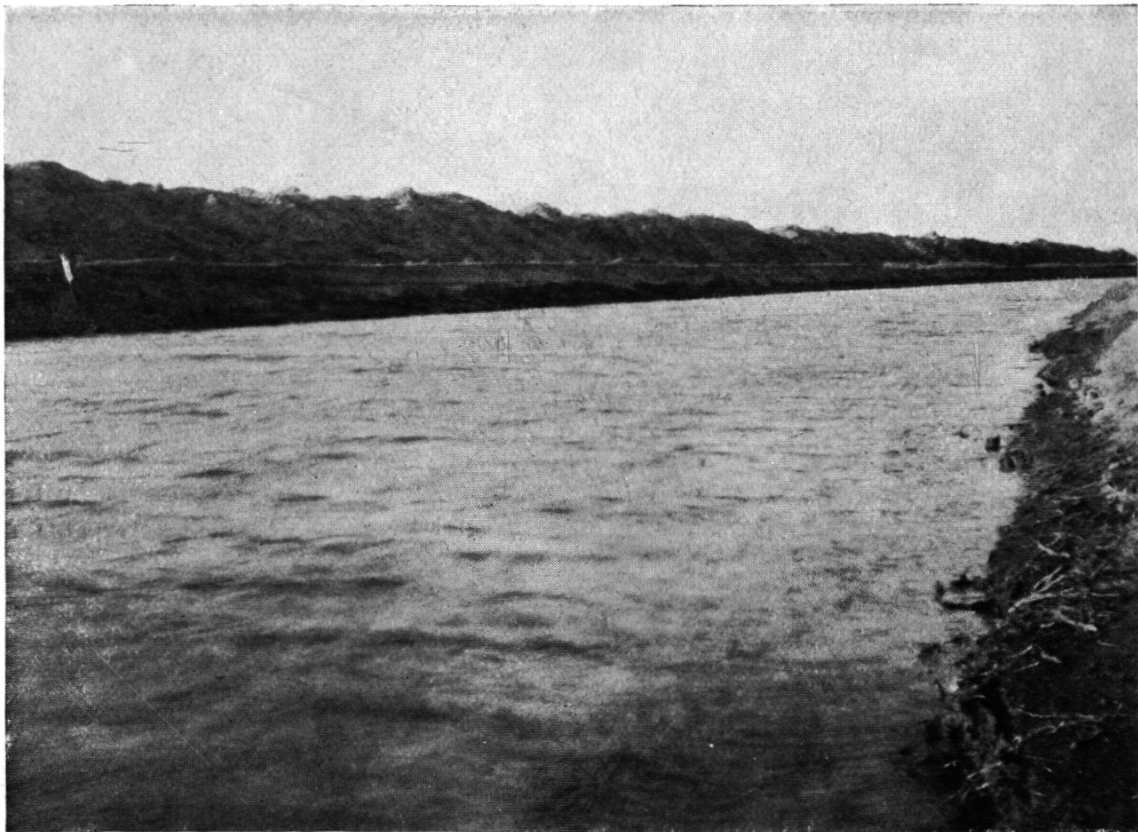
Figur 7. Hauptkanal der Entwässerung des Ardjan- und Amatovosees in der Wardarebene. Auf dem jenseitigen Ufer Aushubsmaterial.
