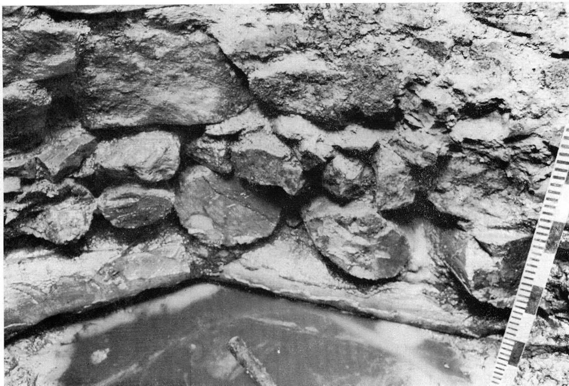
Fig. 6. Bruges : les poutres des assises inférieures de la fondation.
