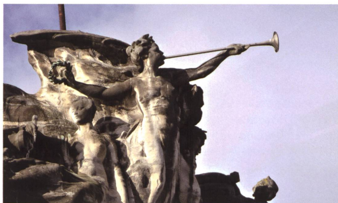
2 Détail du fronton, très abîmé par les intempéries, qui orne la façade principale du musée.
