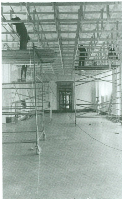
13 (à gauche). La grille technique en montage, 1974 (CIG/BGE, collection Vieux-Genève, sans inv.)
