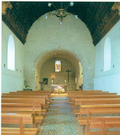
24. Presinge, église Saint-Félix | Vue intérieure de l'église avant la campagne de fouilles archéologiques. On distingue bien son chœur rectangulaire voûté en berceau dont l'édification pourrait se situer au XII e -XIII e siècle.
