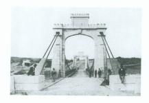
4. Hermann Hug (1825-1888) | Portiques du pont de Peney, 1851-1852 | Les portiques sont les seuls éléments qui ont subsisté de la construction originale après l'écroulement de 1852 (photographie originale d'une collection perdue).
