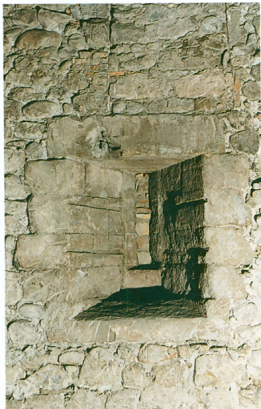
15. Rue de Coutance n° 8 bis « ouest » | Archère découverte au rez-de-chaussée dans le mur donnant sur les vignes et prés épiscopaux. La façade arrière des maisons médiévales constituait alors un véritable front de fortifications.
