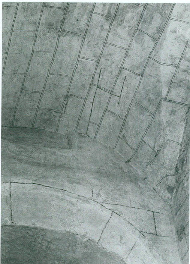
1. Romainmôtier (Vaud), bas-côté méridional de la nef, faux appareil noir à joint blanc, XII e siècle ?, avant restauration. Ce fragment a été dégagé lors de la restauration de 1899-1915 et conservé comme témoin; l'appareil simulé rouge à double joint correspond à une étape ultérieure.
