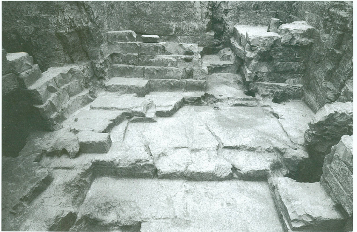
9. Le radier de fondation, vue en direction de l'est (1997)
