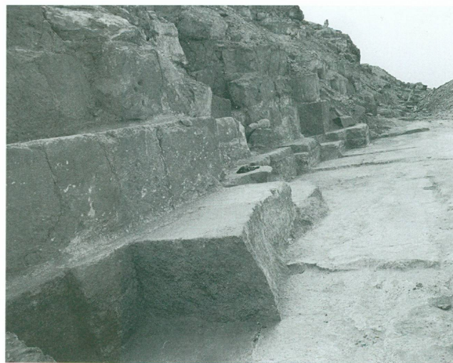
3. Fondation à lit déversé et backing stones de la face est (1997)
