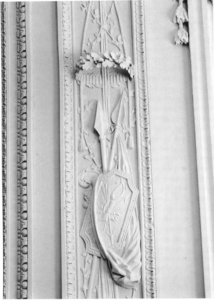
12. Détail de la sculpture du trumeau situé au-dessus de la grande console avec trophée guerrier dans le goût antique.
