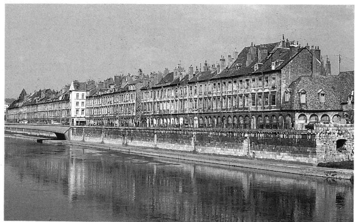
25. Besançon, quai Vauban.
