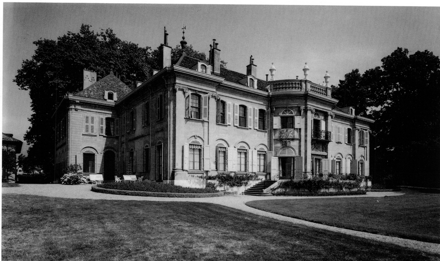
13. Château de Crans, photographie de la façade côté lac.
