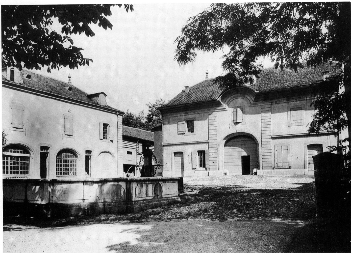
2. Photographie d'une partie des dépendances de La Grange, qui datent de l'époque de construction de la maison de maître. Elles se composent d'une maison d'habitation, d'une grange, d'une écurie et d'une remise, de couverts et à l'origine d'une serre. Il se dégage une unité certaine de ces bâtiments construits avec les mêmes matériaux, rythmés par les mêmes baies et marqués par les mêmes lignes verticales. Les divers éléments d'architecture ne sont pas sans analogies avec la maison de maître : pilastres de refends, lucarnes à volutes, toits en croupe, centre mis en évidence par une niche cintrée, substitut du fronton (MVG).
