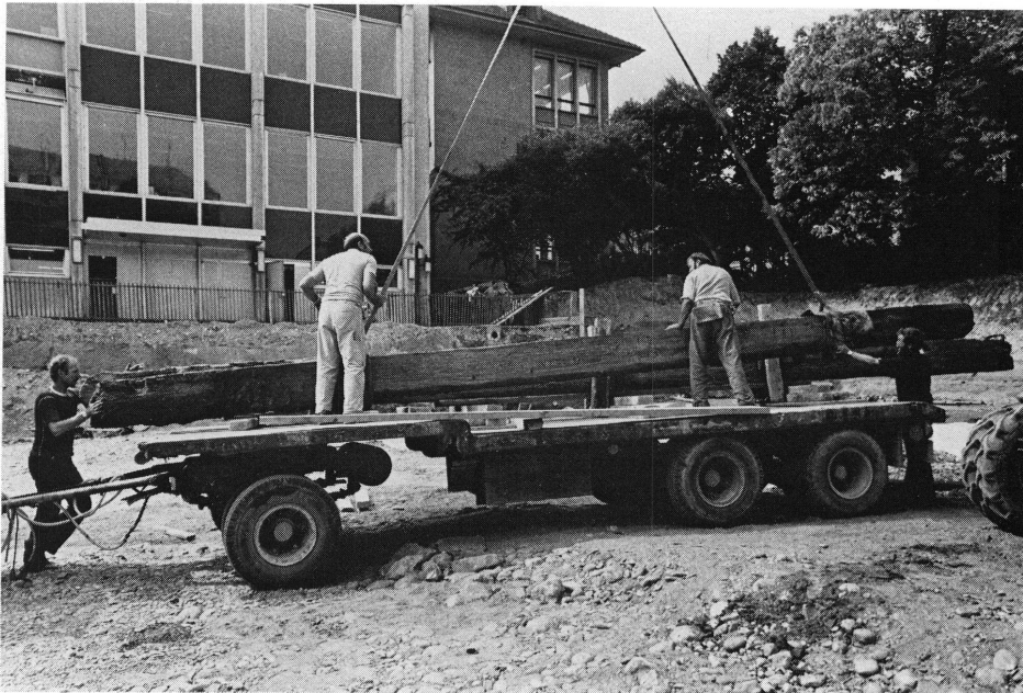
21. Transport des poutres de sapin.
