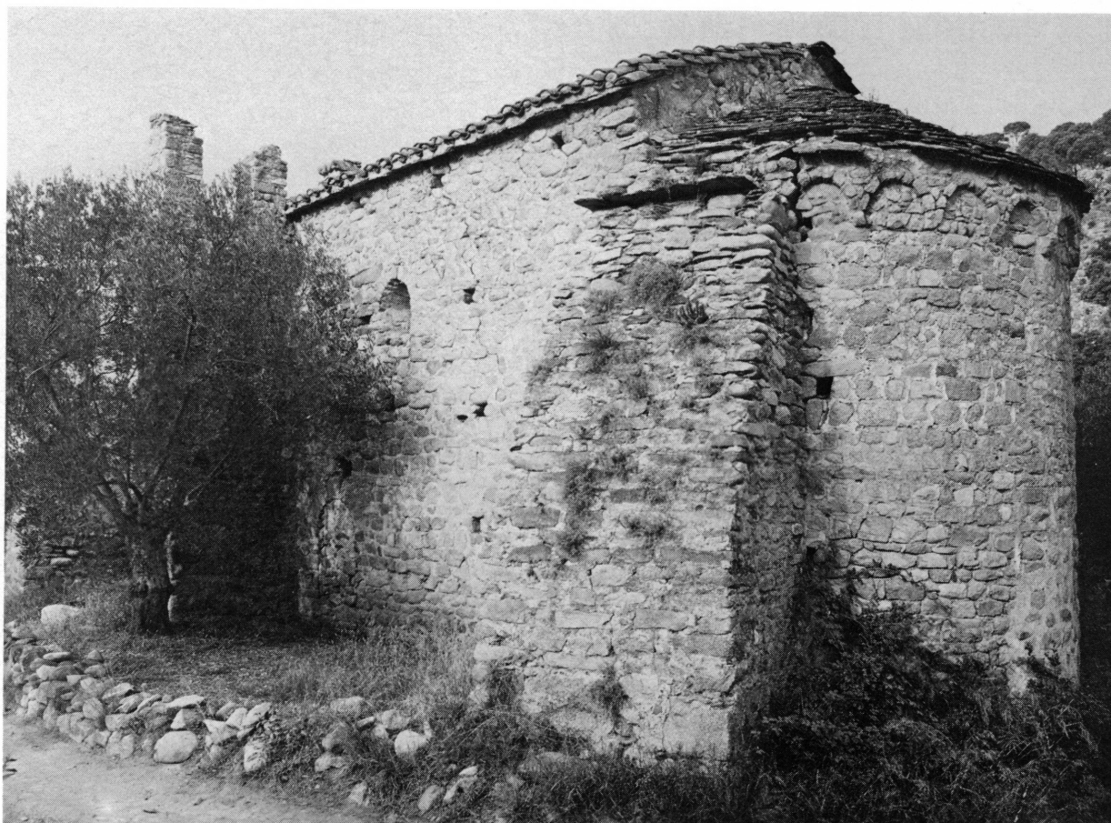
Fig. 1. Casenoves. L'église des Saints-Just-et-Pasteur.
