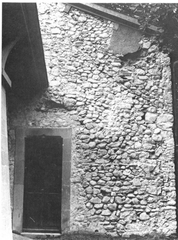
Fig. 25. Annexe nord-ouest. On remarque les modifications apportées à la pente de la toiture lors de la création d'un étage.
