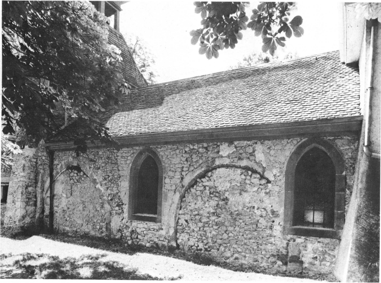
Fig. 21. Mur latéral sud de l'église.
