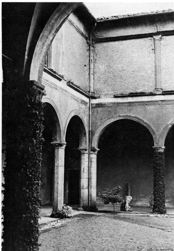
Fig. 6. La Crescenza. Vue de la cour sud.
