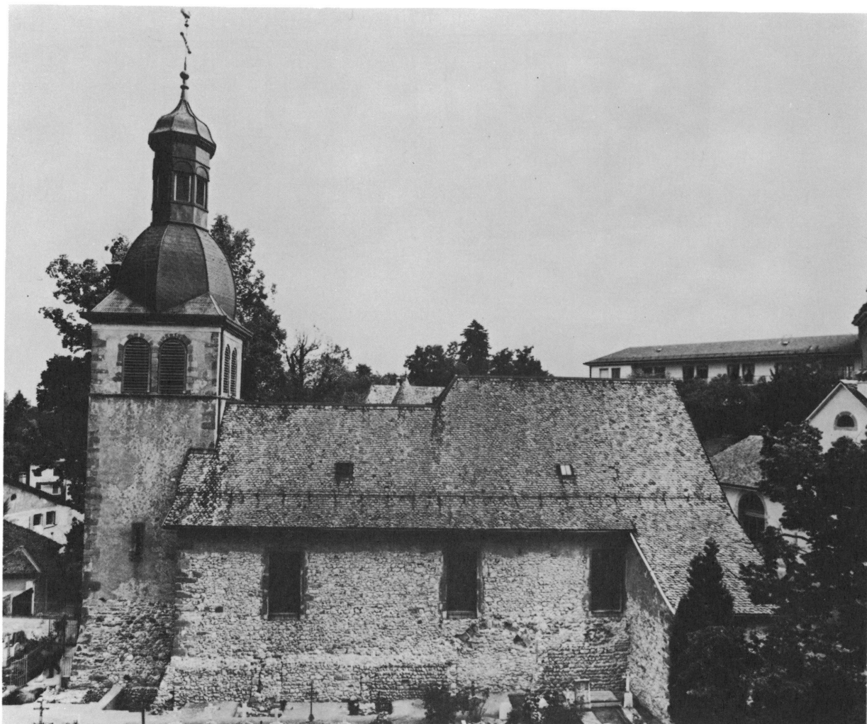
Figure 44. Mur latéral sud de l'église.
