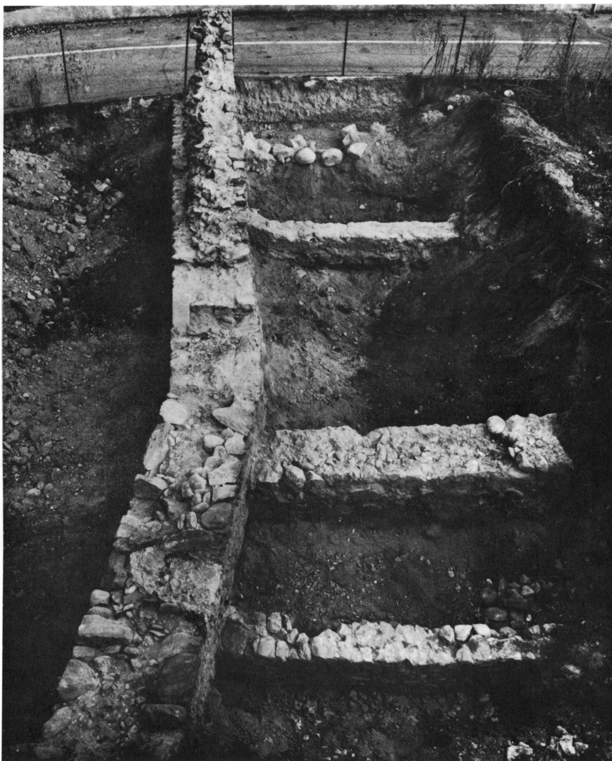
Figure 16. Rempart nord du Bourg-d'en-Bas.
