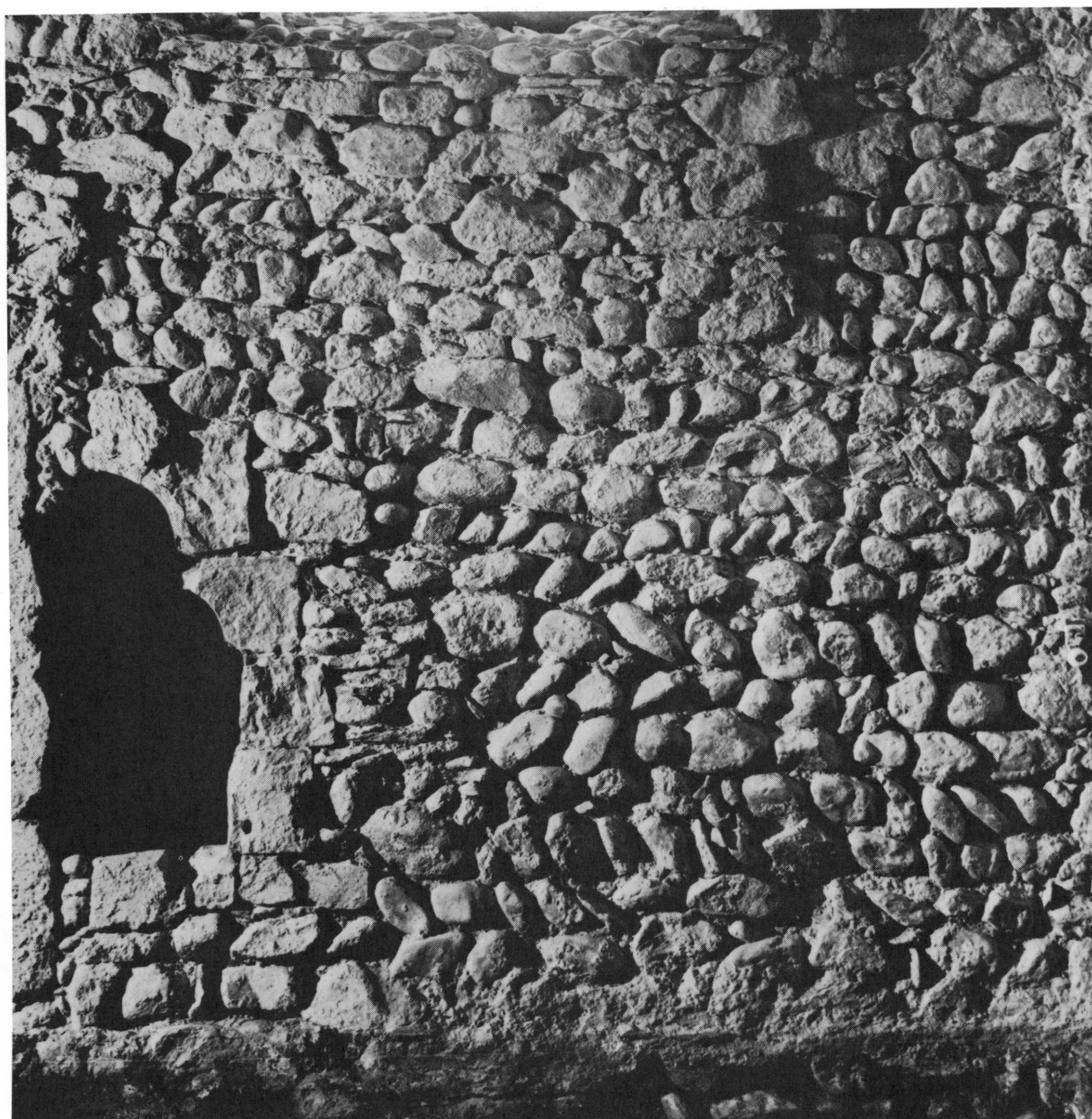
Figure 24. Paroi intérieure sud du chœur, première travée.
