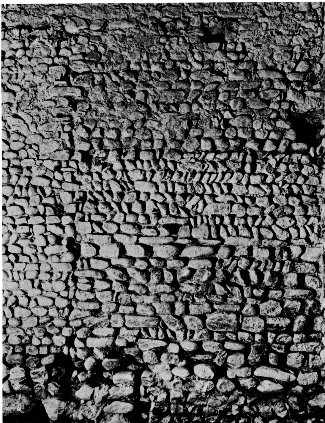
Fig. 29. Agrandissement de la première église, mur sud. Les fondations du premier mur de façade sont visibles au bas de la photographie.
