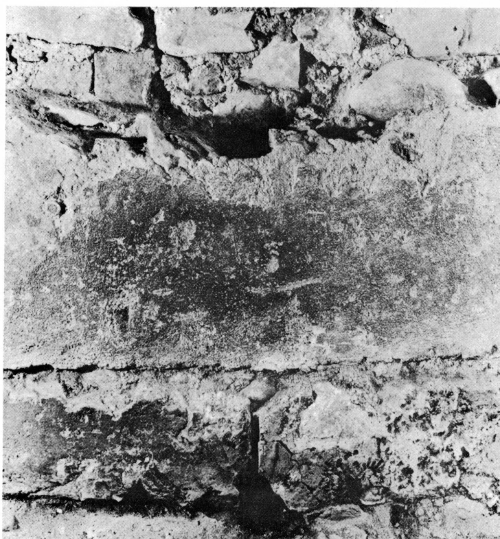
Fig. 47. Emplacement des scellements de la barrière du chœur établie après 1685.
