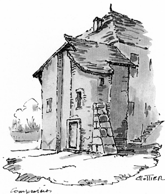
Fig. 11. L'un des angles de la commanderie avant les restaurations de 1953-1954 qui rétablirent le haut des tours (dessin de Louis Cottier).
