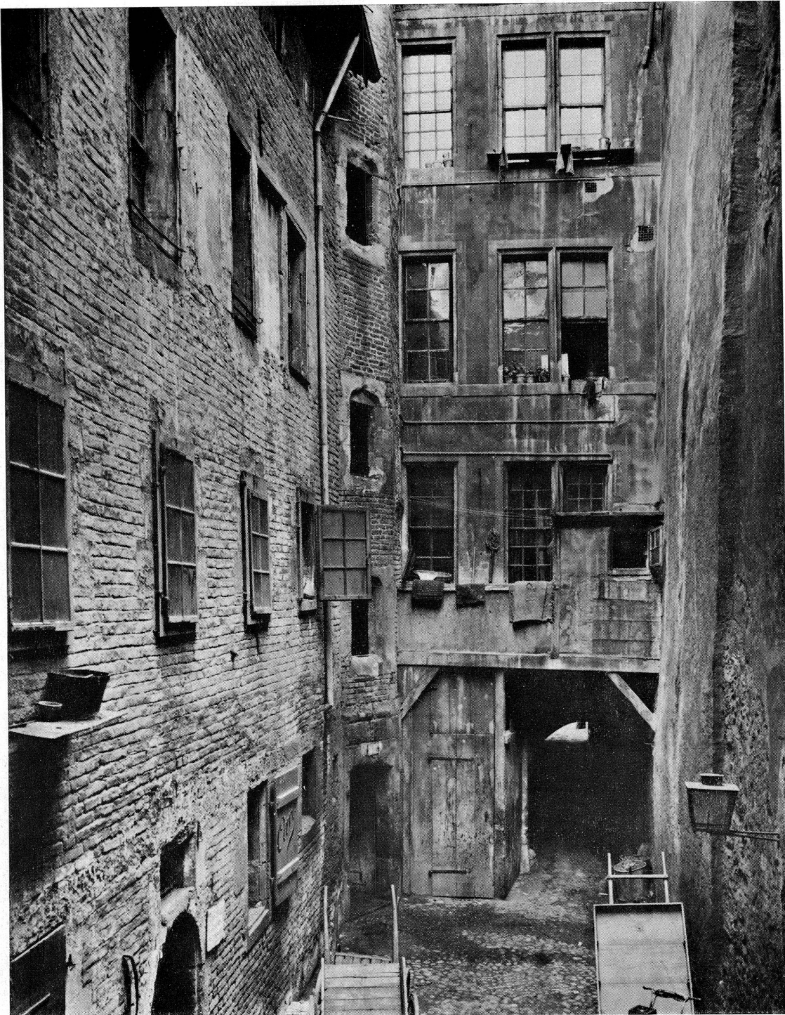
Fig. 4. Première entrée et tour de l'escalier principal.
