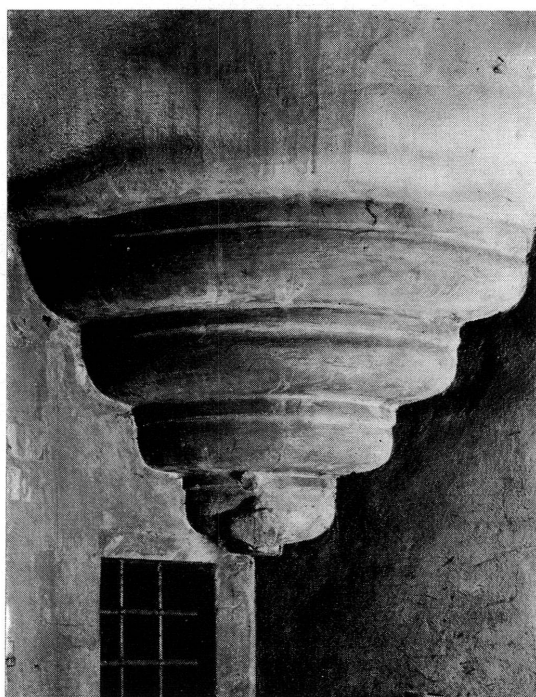
Fig. 12. Base de la Tourelle en encorbellement.
