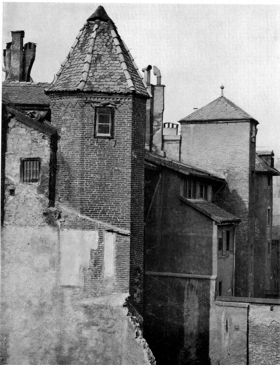
Fig. 6a. Tour principale de la maison de l'évêque de Nice et tour de Versonay.
