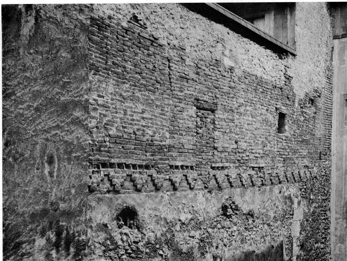
Fig. 10. Décoration en briques: le mur mitoyen.
