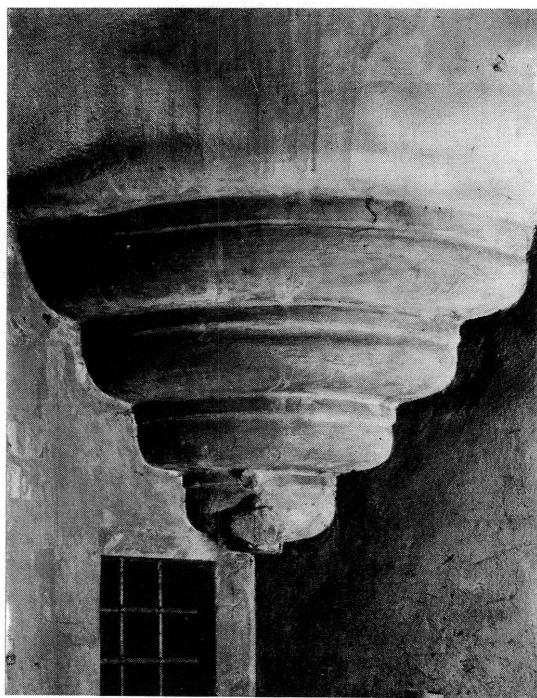
Fig. 12. Base de la Tourelle en encorbellement.
