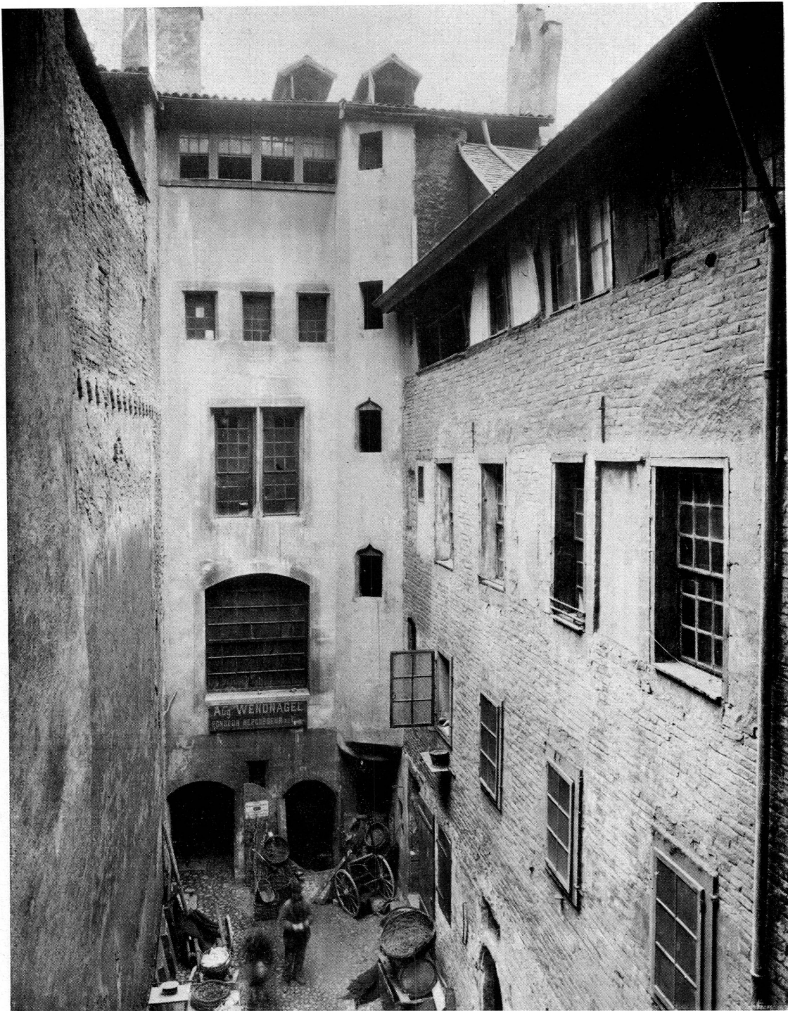
Fig. 8. Première cour avec tourelle en encorbellement.
