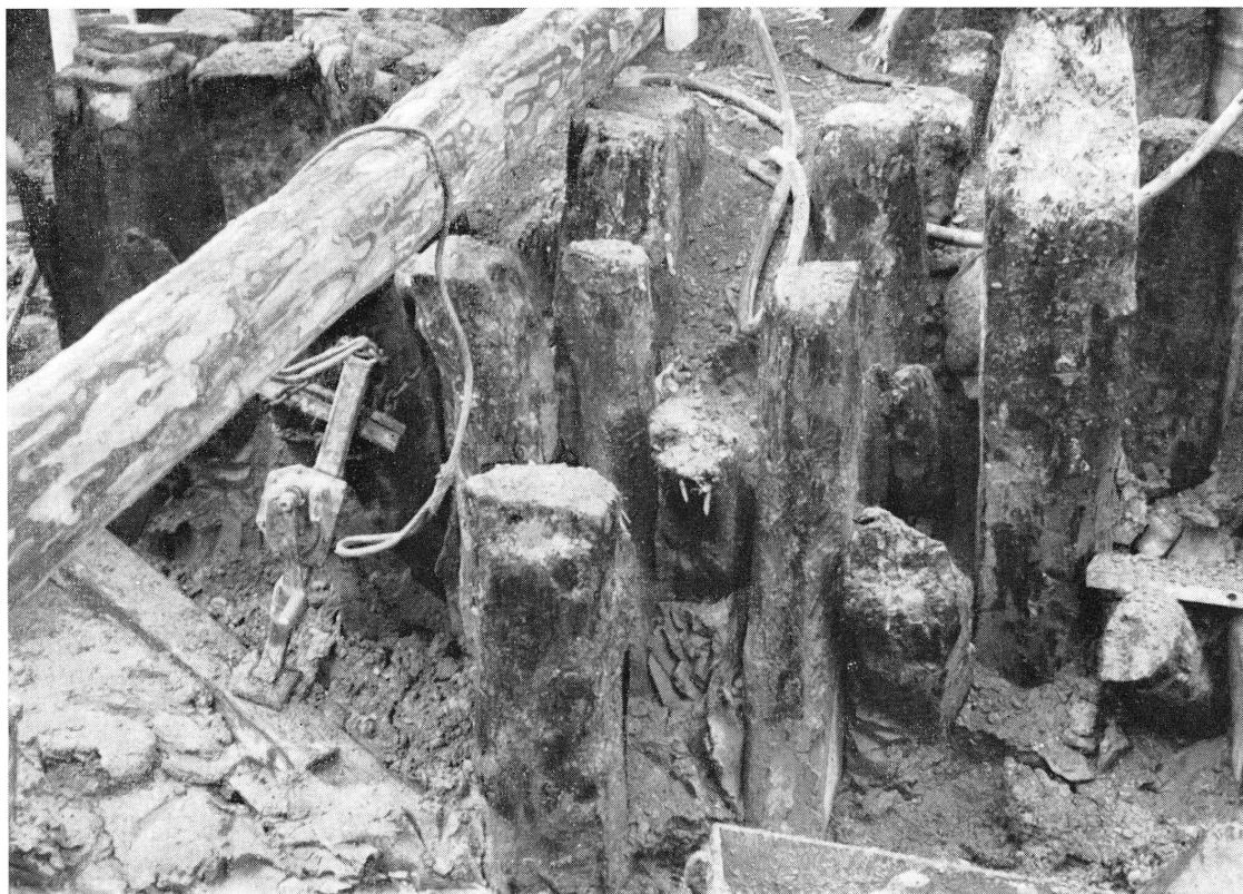
Fig. 139. — Pont romain de Genève. Base de la pile B. (Photo Boissonnas)
