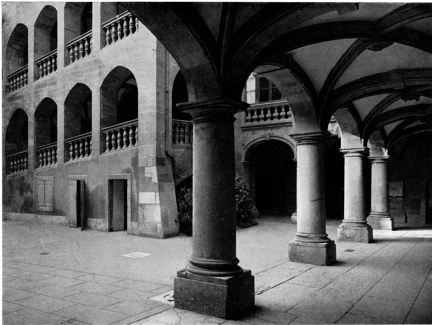
FIG. 220. — Portique et cour de l'Hôtel de Ville.
