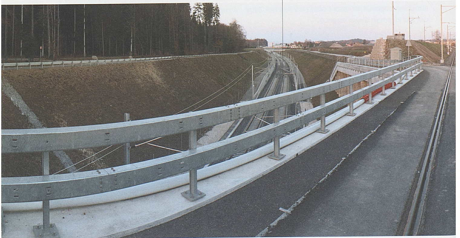
Neubaustrecke Bahn 2000, zwischen Langenthal und Herzogenbuchsee
