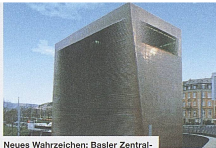
Neues Wahrzeichen: Basler Zentralstellwerk von Herzog & De Meuron
