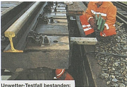
Unwetter-Testfall bestanden: Brückenanhebung im Wallis
