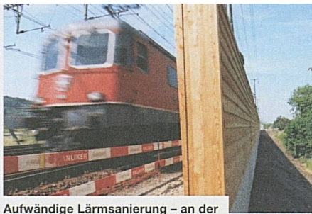
Aufwändige Lärmsanierung – an der Quelle und mit Schutzwänden
