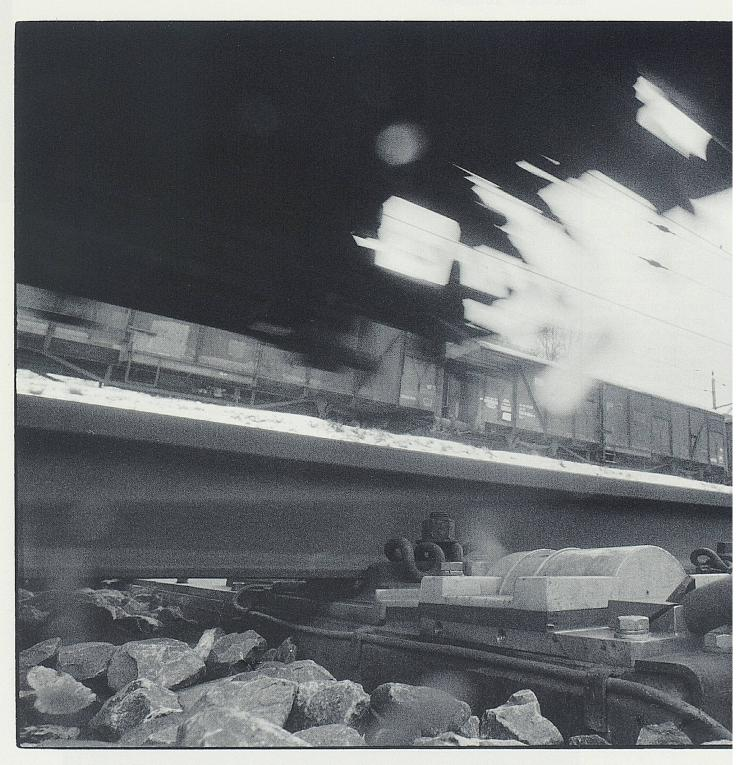
Elektronische Sicherheit... Sensible Technik ortet heissgelaufene Achslager und festsitzende Bremsklötze vorüberrollender Züge zuverlässig. Die Zahl solcher Kontrollpunkte wurde merklich erhöht.
