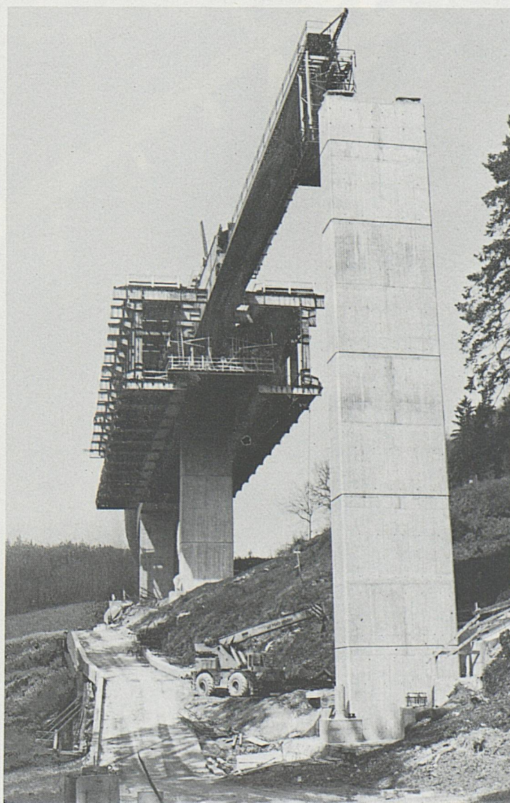
Vorschubgerüst mit ausgefahrenem Vorlaufträger
