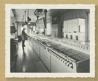
Erstes elektromechanisches Schalterwerk der SBB vom Typ VES in Biel, Inbetriebnahme 1924
