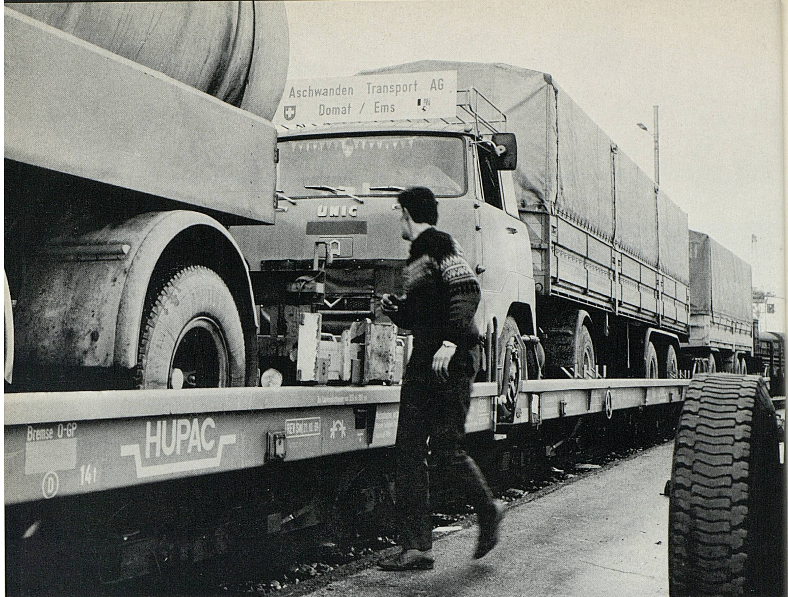
Im Huckepackverkehr werden schwere Lastwagen samt Anhängern auf besonderen Bahnwagen rasch über weite Distanzen transportiert.
