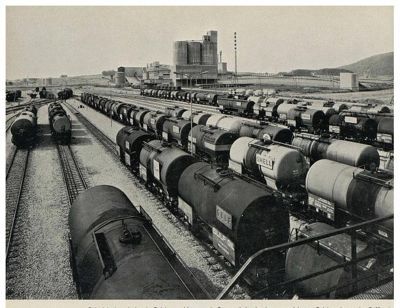
Beispiel eines Industrie-Geleiseanschlusses mit Grossverkehr: In den ausgedehnten Geleiseanlagen der Raffinerie Cressier stehen Kesselwagen zur Überfuhr nach Cornaux bereit. Dort werden Blockzüge sowie Zielzüge nach bestimmten Zonen gebildet und zu den Verbrauchszentren geführt.
