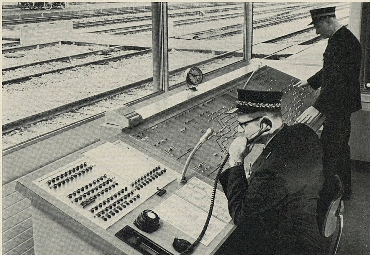
Modernes Domino-Stellpult der neuen Stellwerkanlage des Bahnhofs Ziegelbrücke...
