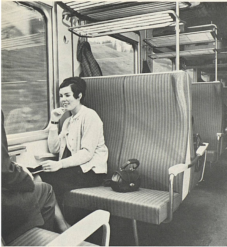
Der Prototyp des neuen Einheitswagens 2. Klasse mit Gummiwulst statt Faltenbalg, Fenster mit Doppelverglasung, Fluoreszenzleuchten und neu gestalteten Sitzen
