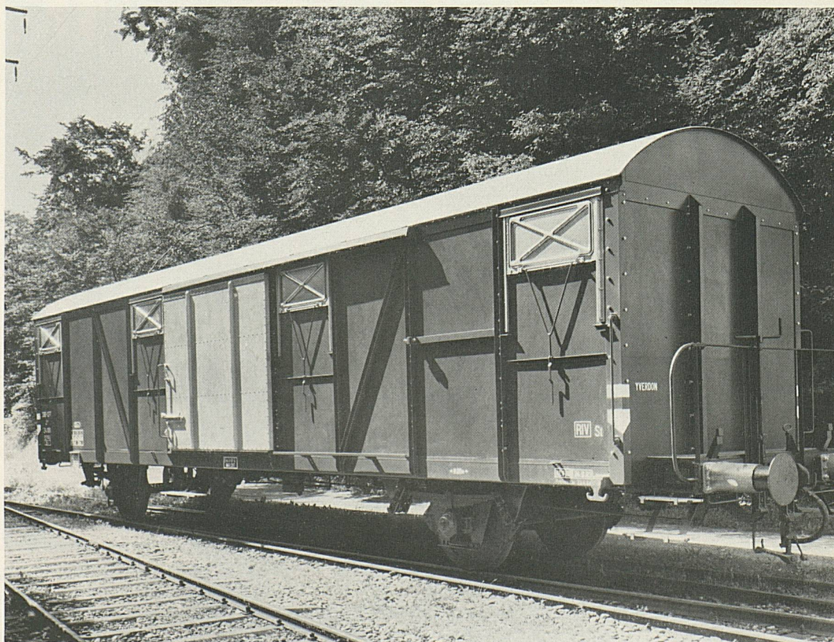
Der neue Grossraum-Güterwagen des Typs Hbs (früher J 4) mit 87 m 3 Laderaum und einer Tragfähigkeit von 26 t
